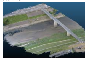
奈良県大和川多聞橋
