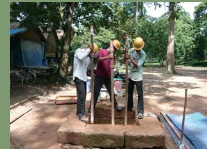
細かい粒子の砂に水を加え突き固める工法で、版築と 呼ばれる盛土をテストサイトにて再現
